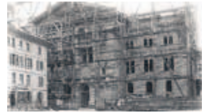
Das Parlamentsgebäude im Bau.
